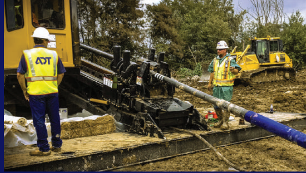
B/S/H, Çerkezköy Yönlendirilebilir Yatay Sondaj Çalışmaları
