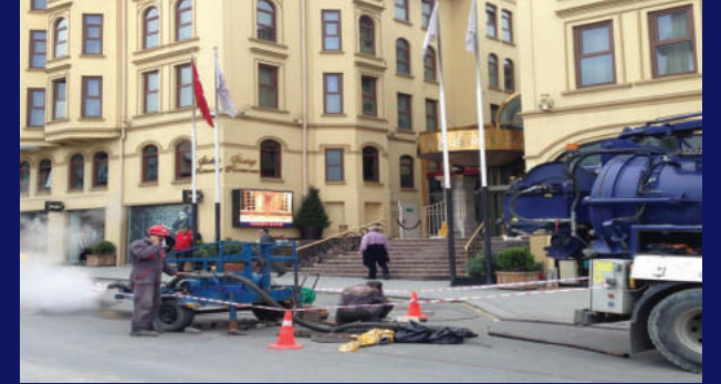
İSKİ, İstanbul Kazısız Rehabilitasyon, Çalışmaları
