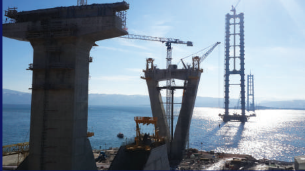
Körfez Geçiş Köprüsü, İzmit Ard Germe Borularının Rehabilitasyonu Gulf Passing Bridge, İzmit Rehabilitation of Back Tension Pipes
