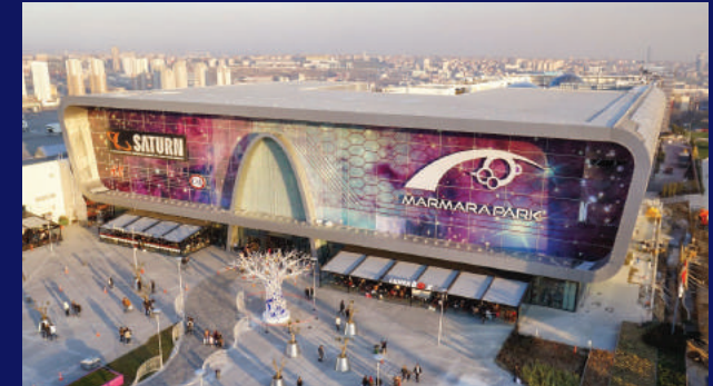
Marmara Park AVM, İstanbul Kazısız Rehabilitasyon Çalışmaları Marmara Park AVM, İstanbul Trenchless Rehabilitation Works
