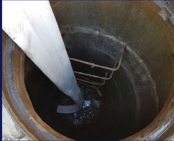
A noktasından B noktasına doğru kanal içerisinden çekilir. It is drawn from A point to B point through inside of channel.
