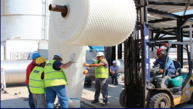
Opet , Marmara Ereğlisi Kazısız Rehabilitasyon Çalışmaları
