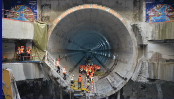
Avrasya Tüneli Tali Hatların Görüntülenmesi İşi
