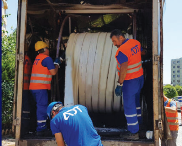
A noktasından modifiye PVC boru verilir. Modified PVC tube is drawn from A point.
