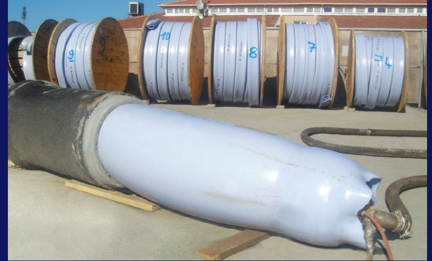
Çekilen modifiye PVC boru buhar basıncı ile şişirilir ve soğutulurak mevcut boruya entegre edilir. Drawn modified PVC tube is pumped up through vapour pressure and is integrated on to existing tube by being cooled.
