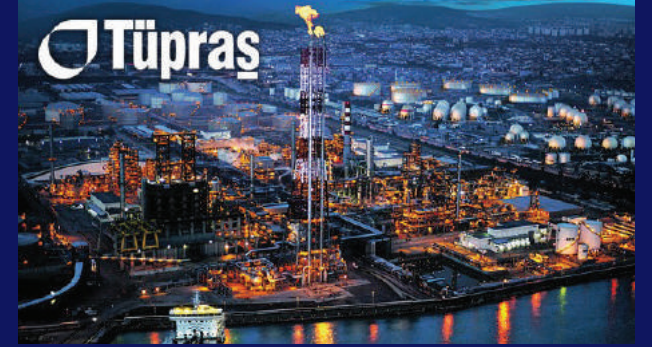
Tüpraş, İzmit, Batman, İzmir, Kırıkkale Kazısız Rehabilitasyon Çalışmaları
