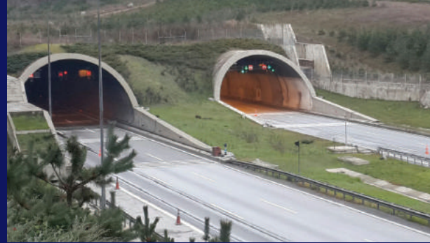
Bolu Dağı Tüneli Drenaj Kanallarının Rehabilitasyonu Bolu Mountain Tunnel Rehabilitation of Drainage Channels
