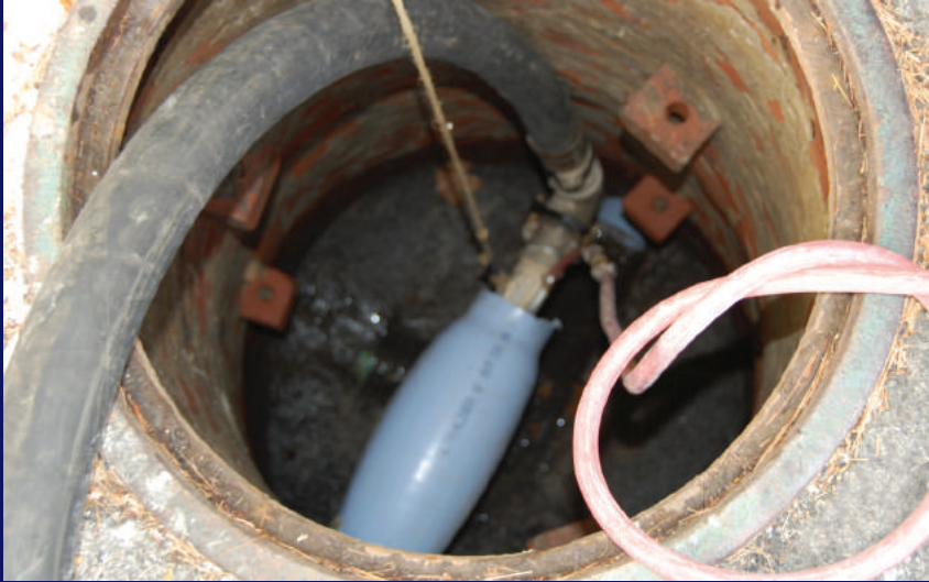
A ve B noktalarına özel buhar tıpaları takılır. Special vapour closures are mounted on A and B points.
